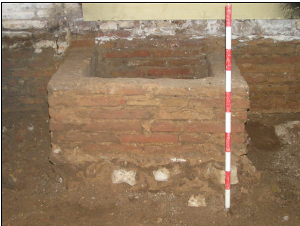
Foto. Vista de l'alçat exterior del pou o fossa sèptica U.E. 102
