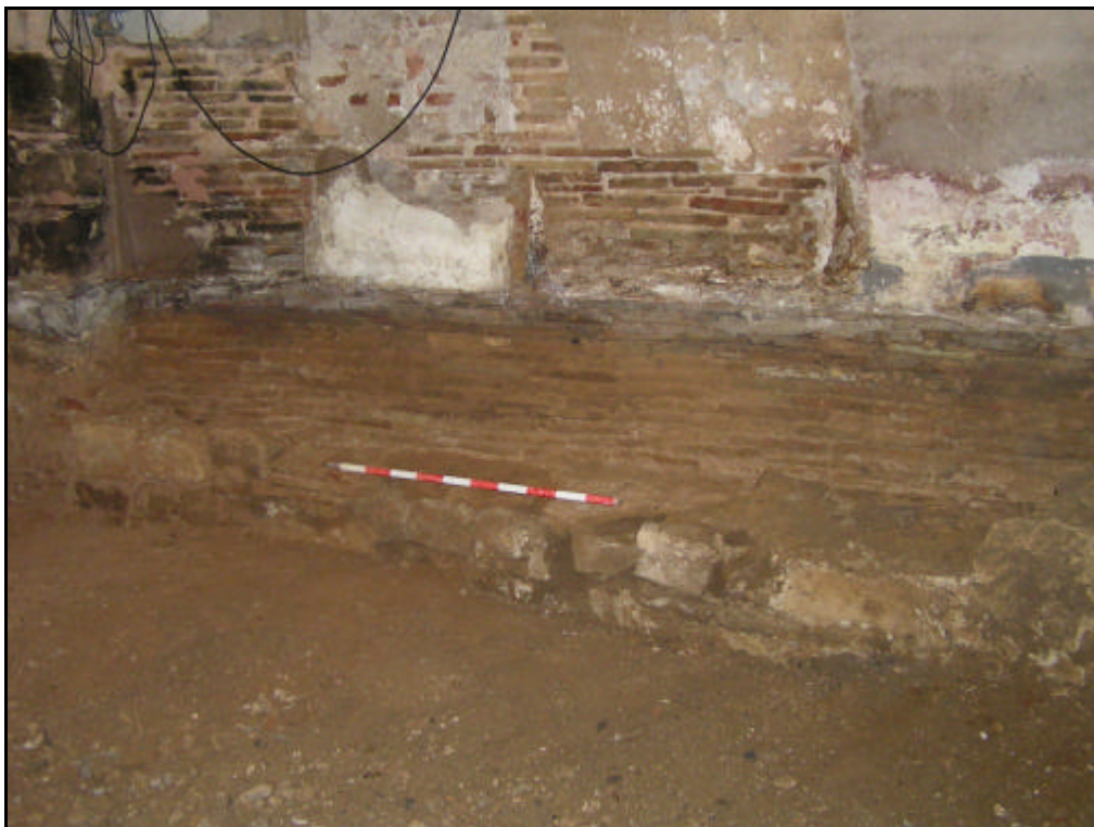
Foto. Vista frontal del mur U.E. 108
